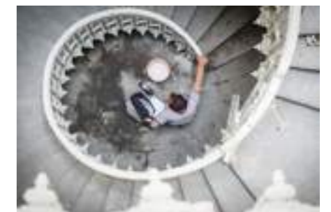
DESTRA Lavori di ristrutturazione in un palazzo storico
