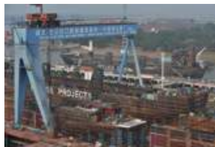
SINISTRA Navi in costruzione presso il cantiere cinese Qingshan
