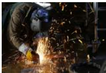
SINISTRA Lavori di saldatura
