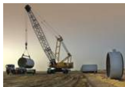
DESTRA La prima fase dell'opera è stata ultimata nel 1991
